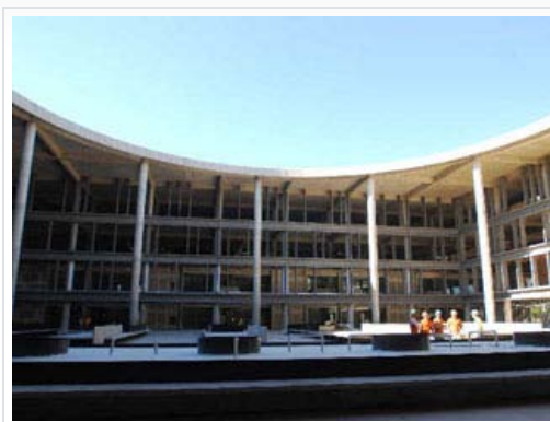
Obras de la ciudad judicial. Se esperaba que este mes comenzara la mudanza de sus futuros inquilinos. Foto: Marco A. Vargas
